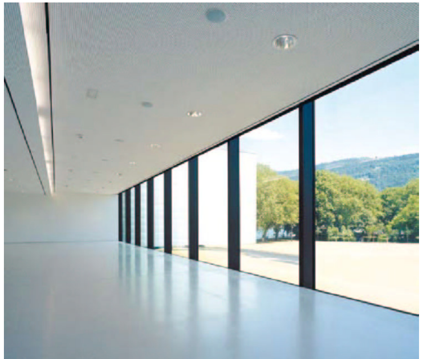
Linear diffuser INDUL in the Festspielhaus
