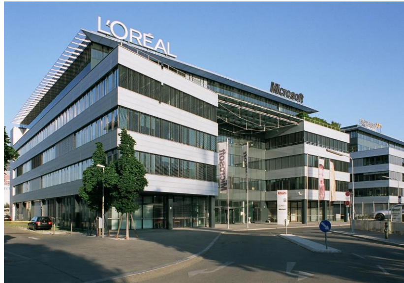
EURO PLAZA Wien Bauphase 1
