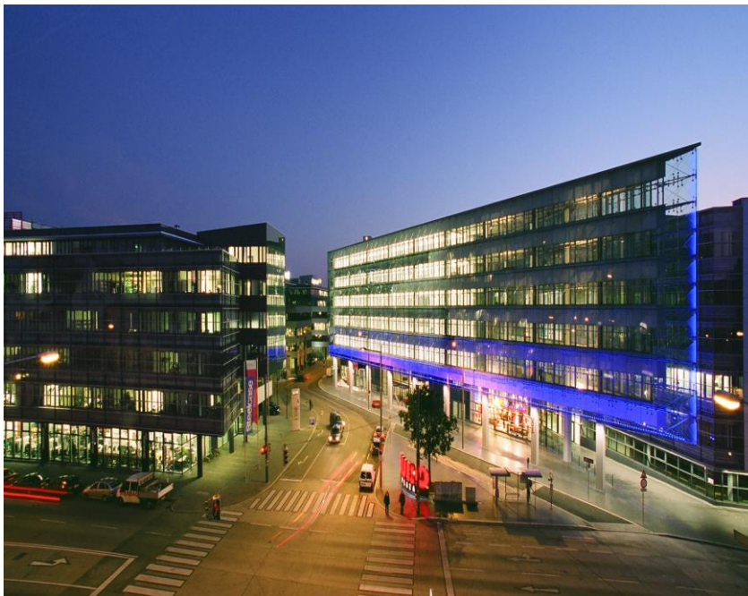
EURO PLAZA Wien Bauphase 4
