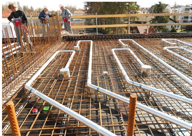
Bild 3. Montage des Lüftungssystems CONCRETCOOL
