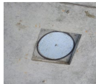
Bild 5. Rückversetzter Auslasskasten (Fotos 3–5: Kiefer GmbH)
