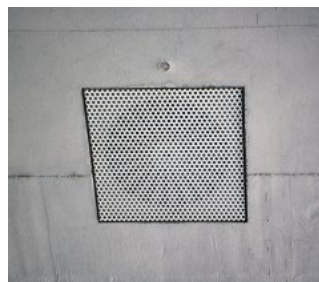
Bild 4. Deckenbündige Zulufteinbringung
