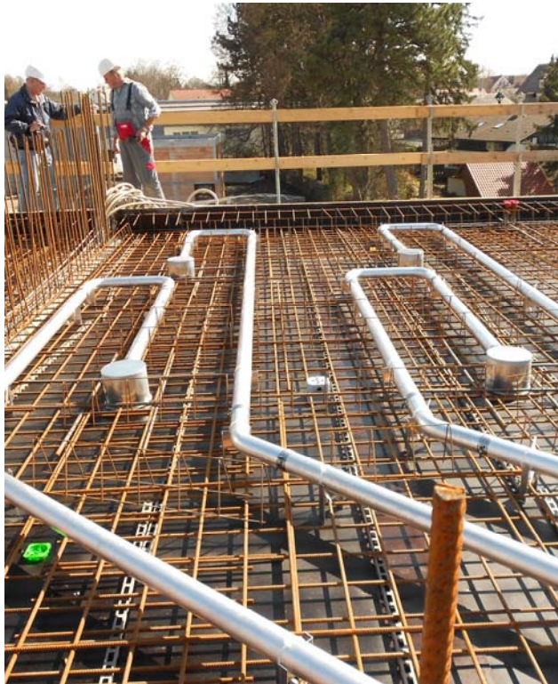
Montage des Lüftungssystems CONCRETCOOL.
