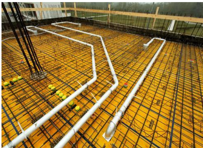
Bewehrungsarbeiten Rohrschlange montage
