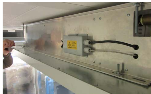
Abbildung 3: Lösen der Mutter (M8).
