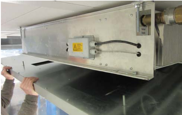
Abbildung 4: Öffnen des Akustiksegels.
