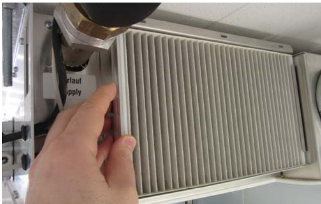
Abbildung 1: Einsetzen der Filterzelle (als Ersatzteil erhältlich).
