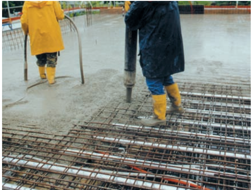
Vergießen der Betondecken mit CONCRET-COOL.
