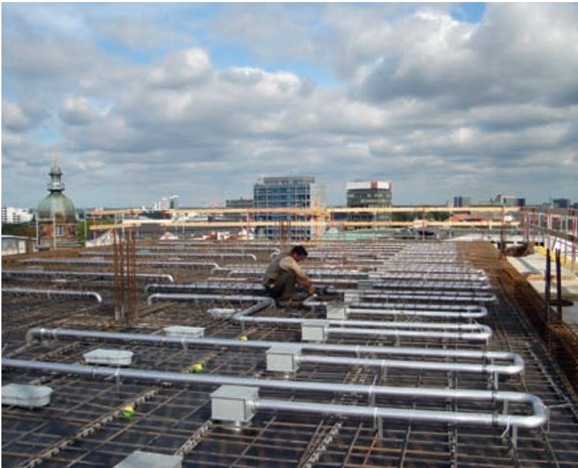
Kühlrohre werden in der statisch neutralen Zone verlegt.
