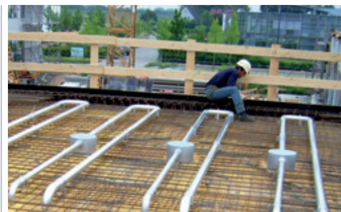
Verlegung der Kühlrohre mit Luftdurchlasskästen auf der unteren Bewehrungslage
