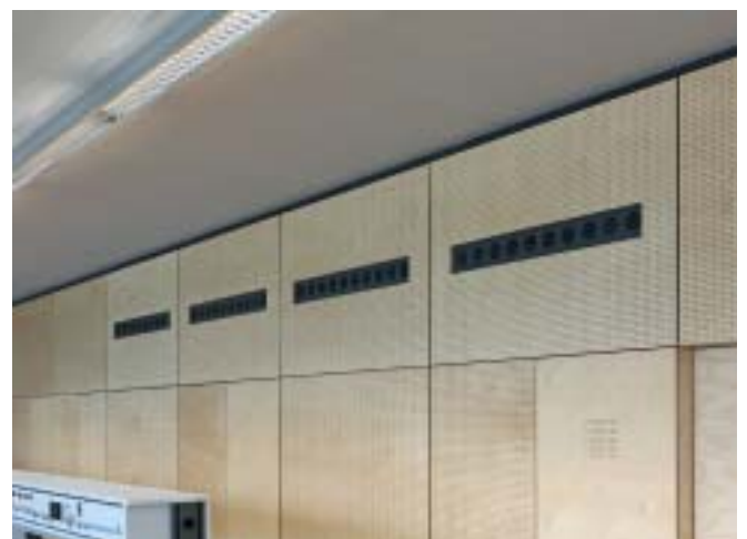
Bauseitige Disposition der Lüftungsrohre: Rohbau – Ausbau
