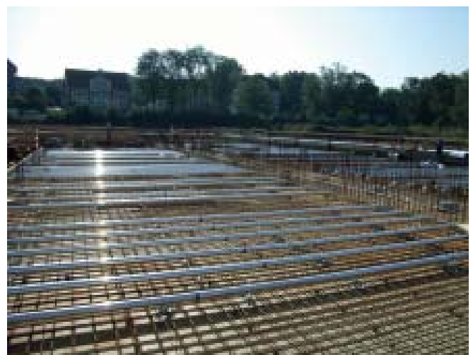
Betonierarbeiten Rohdecke mit Lüftungsrohren
